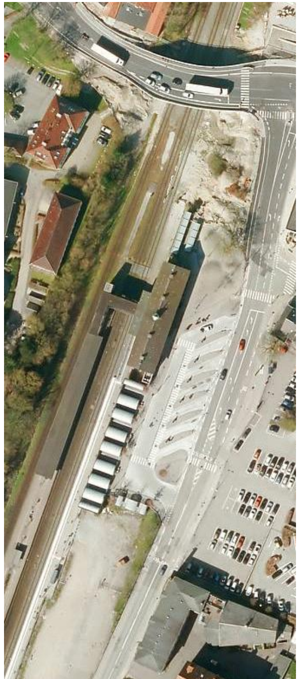
Pakhus, gangbro og vejbro med Næstvej er fjernede, og en ny vejbro og gangbro (ej vist) er bygget. http://map.krak.dk/ , Hybrid etc. ° , Hybrid, 2018
